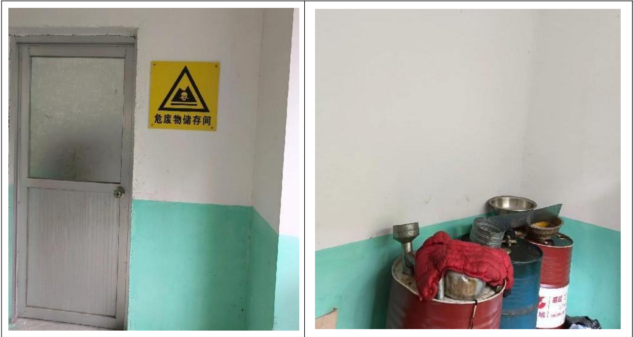
图5-2 项目危废间照片
